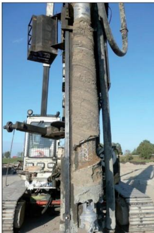
▲ Fot. 3. Formowanie kolumn przemieszczeniowych – świder wyjęty z otworu (fot. K. Grzegorzewicz)
